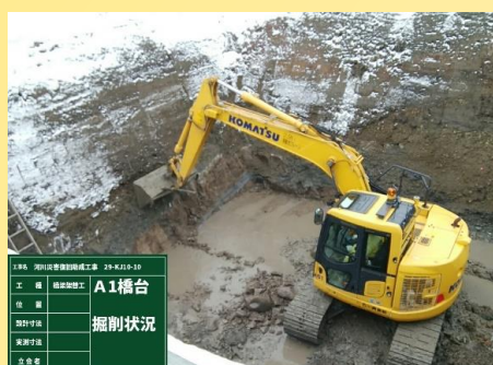
橋台掘削状況
