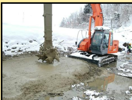
地盤改良状況
