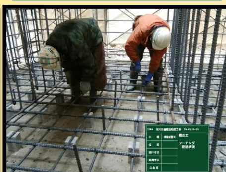
橋台工 配筋状況
