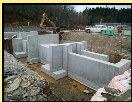
排水樋管工 完成
