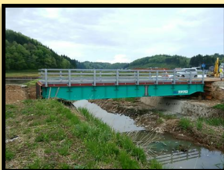
仮設工 仮橋完成
