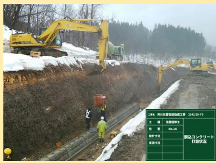
胴込コンクリート 打設状況
