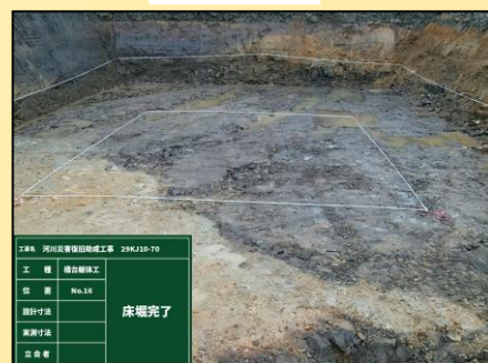
A2橋台 床掘完了
