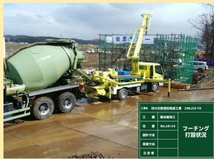
A2橋台フーチング コンクリート打設状況
