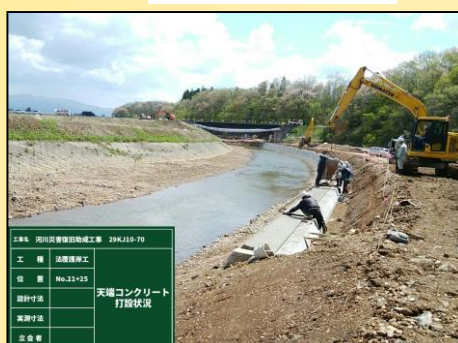
天端コンクリート 施工状況
