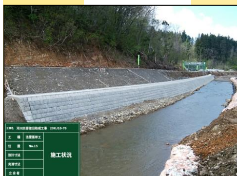
コンクリートブロック積 施工状況
