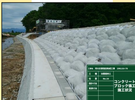
ブロック張 施工状況
