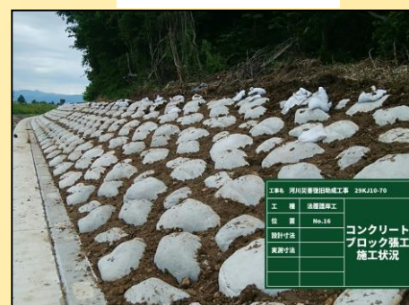
ブロック張 施工状況
