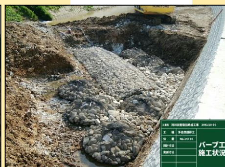
多自然護岸工 施工状況
