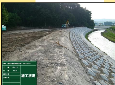
土工 施工状況
