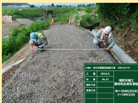
敷砂利 施工状況
