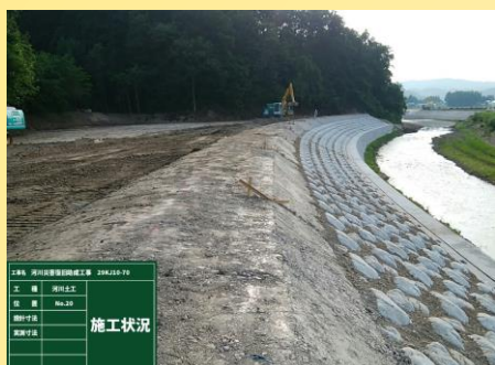
土工 施工状況
