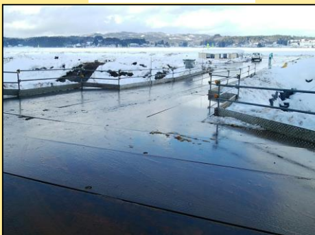
仮設工施工状況
