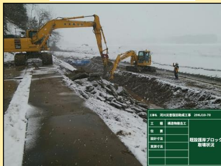
構造物撤去施工状況
