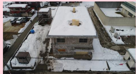
完成(ドローンによる空撮)
