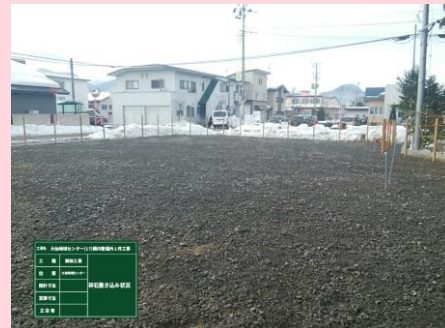
砕石敷き込み
