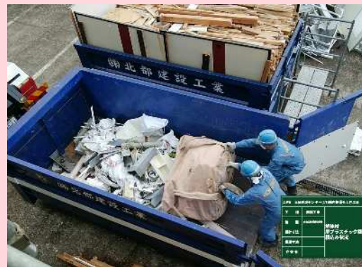
大曲労働基準監督署 解体材積み込み状況
