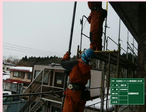
外部足場解体
