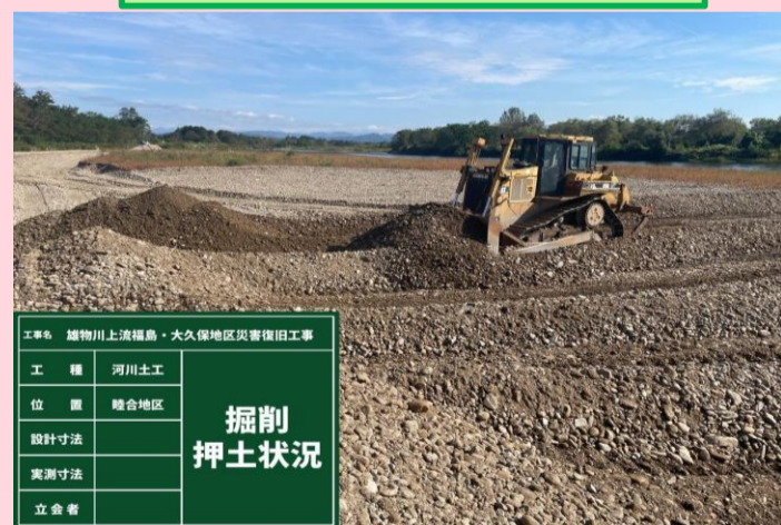
掘削押土状況
