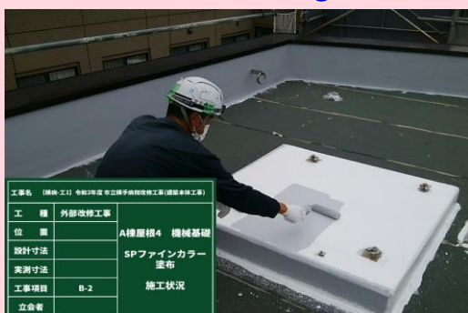
A棟 屋上防水
