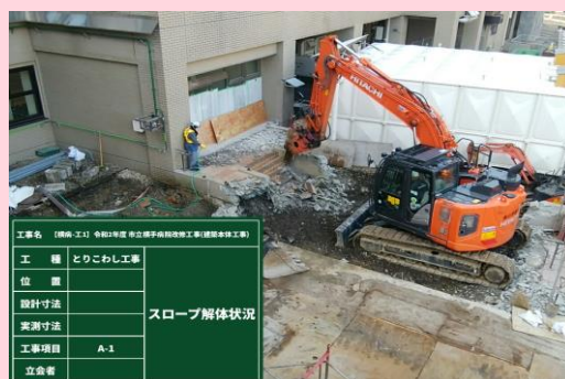
公園口 スロープ解体
