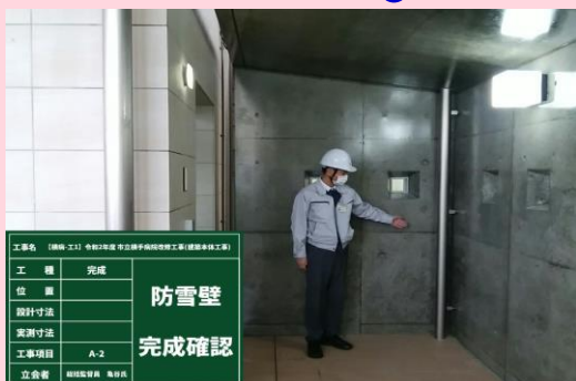
C棟防雪壁 完成
