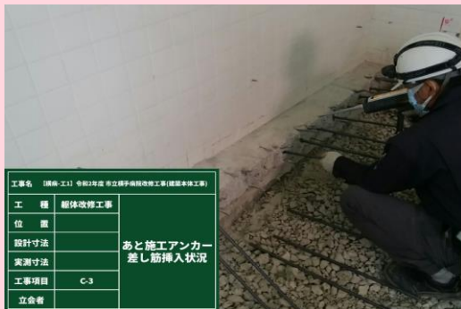
厨房 あと施工アンカー施工状況
