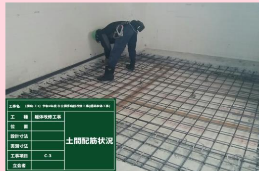
厨房 土間配筋
