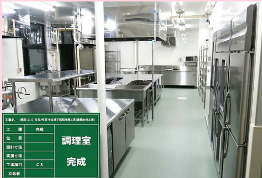
厨房 調理室完成
