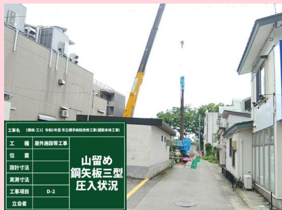
山留め 鋼矢板圧入状況
