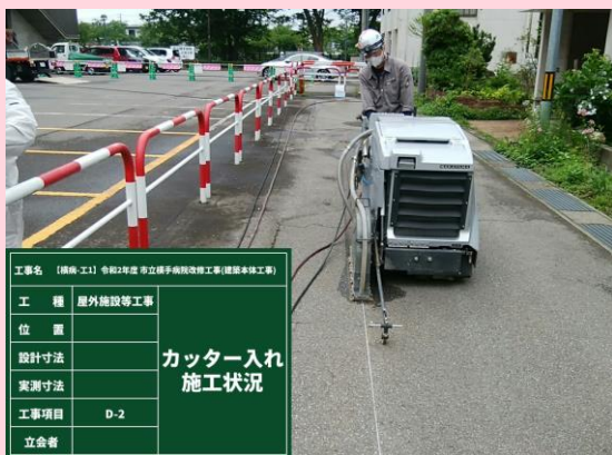
カッター入れ施工状況
