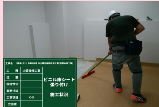
A棟4階 リ初庫 ビニル床シート張り付け状況
