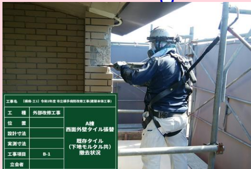
A棟 西面既存外壁タイル撤去
