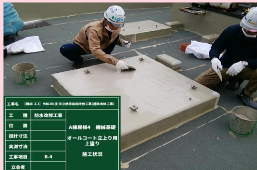
A棟 屋上防水
