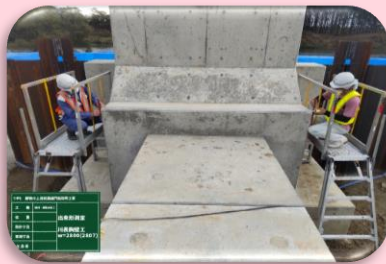
樋門・樋管本体工 出来形検測
