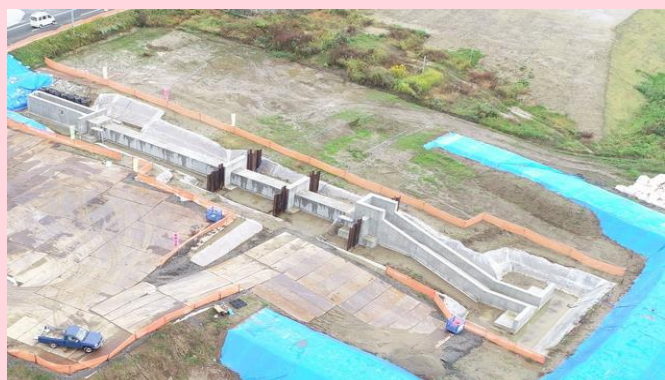
ドローン撮影写真
