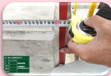
樋門・樋管本体工 数値接写
