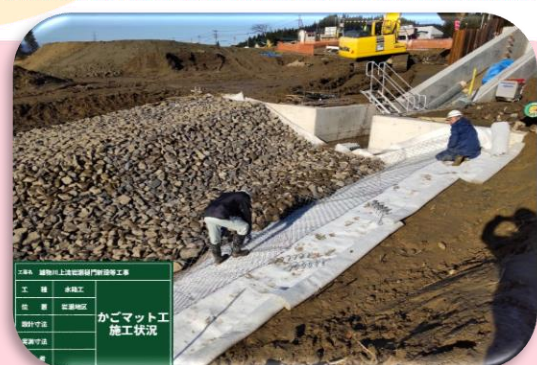
水路工 かごマット施工状況
