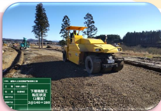
切廻し道路工 下層路盤転圧状況
