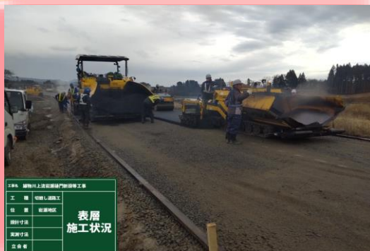
切回し道路工 表層敷均し状況
