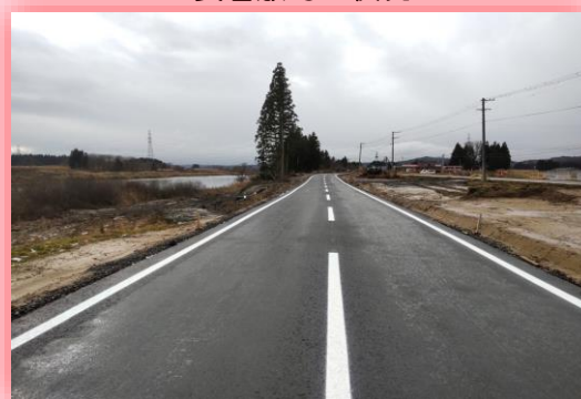
切回し道路工 表層完了
