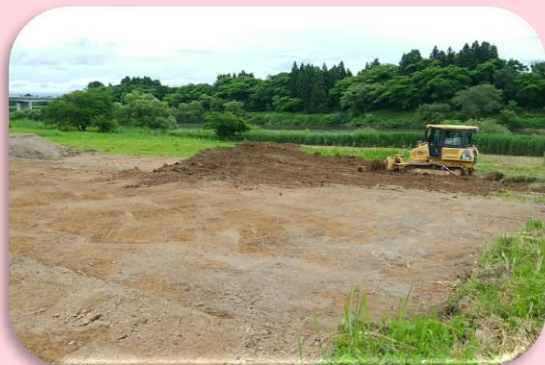
河川土工（表土剥ぎ取り）実施状況
