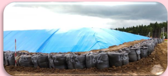
仮設工（土留・仮締切工）完了
