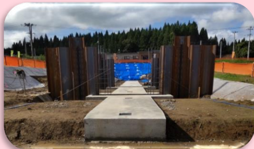
本体工（基礎コンクリート打設）完了
