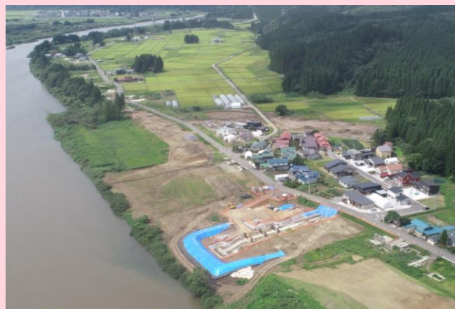
ドローン撮影写真
