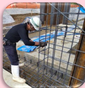
鉄筋組立完了
