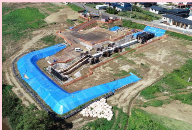
ドローン撮影写真
