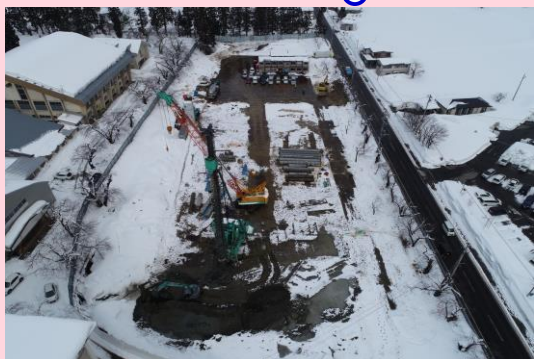
ドローンによる上空からの撮影
