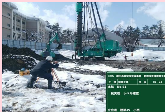
地業工事 本杭施工
