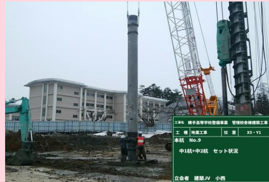
地業工事 本杭施工
