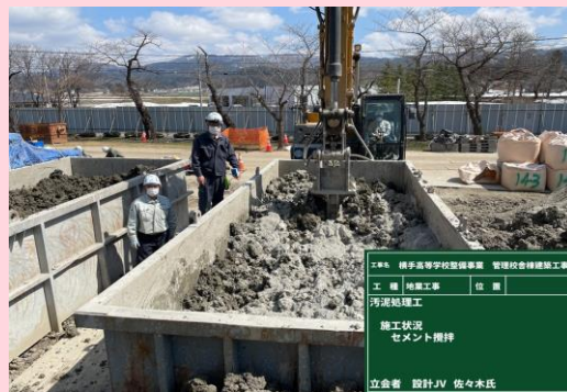
汚泥改良工事 施工状況
