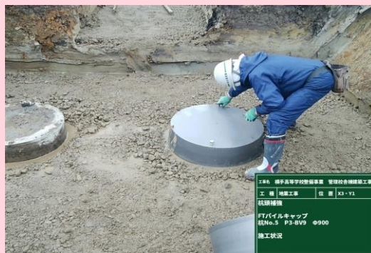
地業工事 施工状況
