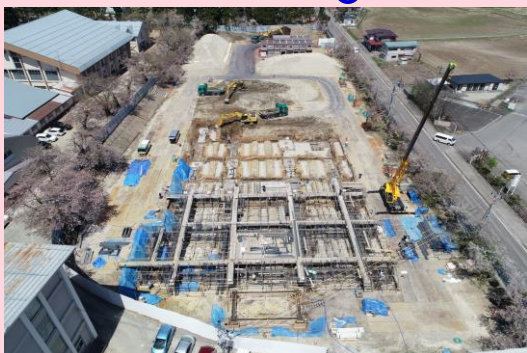
ドローンによる上空からの撮影
