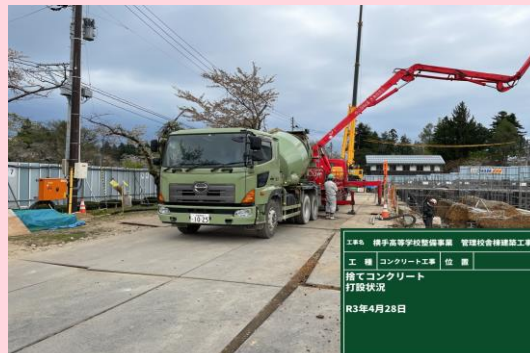
コンクリート工事 捨コン打設状況
