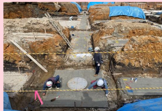
共通仮設工事 墨出し状況
