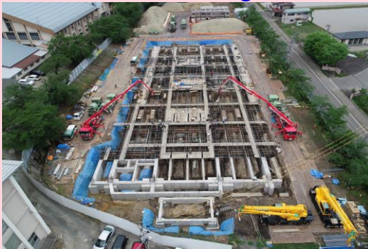
ドローンによる上空からの撮影
