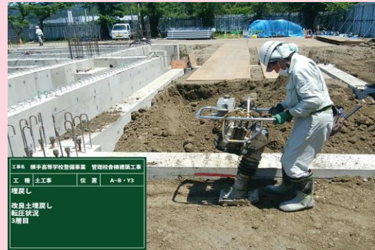
土工事 埋戻し転圧状況
