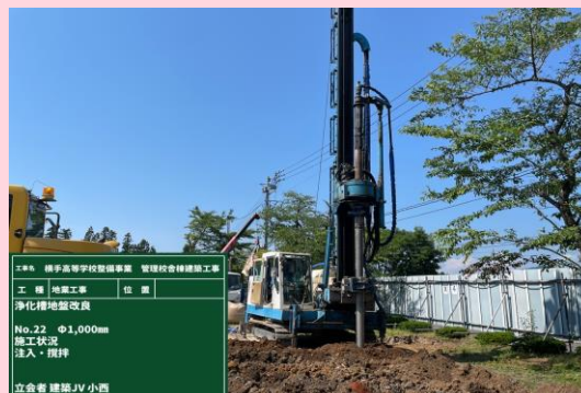
地業工事 柱状改良
