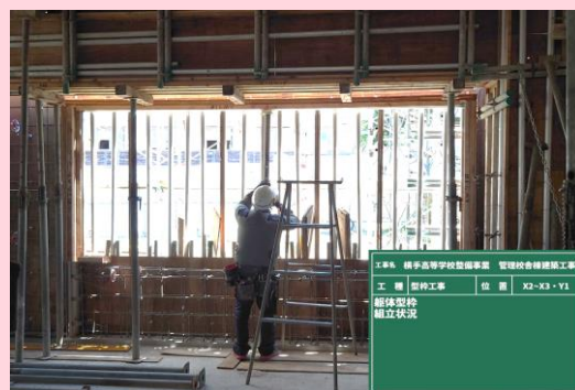
型枠工事 型枠組立状況
