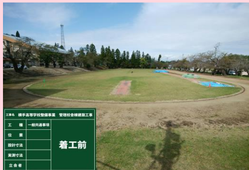
管理校舎棟 着工前 南面
