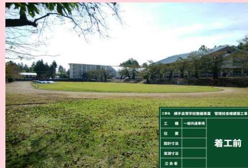
管理校舎棟 着工前 北東面
