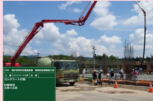
コンクリート工事 打設状況
