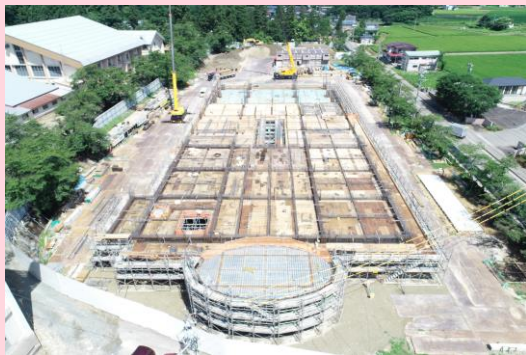
ドローンによる上空からの撮影
