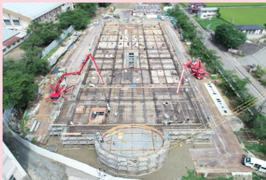
ドローンによる上空からの撮影
