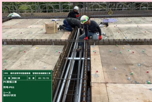
鉄筋工事 PC緊張工 シース取付状況
