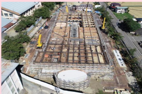
ドローンによる上空からの撮影
