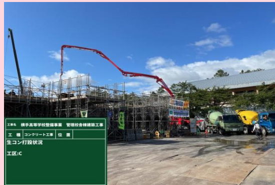
コンクリート工事 打設状況
