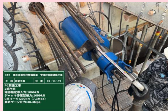
鉄筋工事 PC緊張状況
