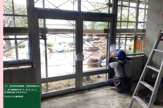
建具工事 1階サッシ取付状況
