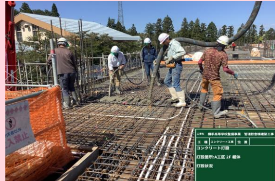
コンクリート工事 2階躯体打設状況
