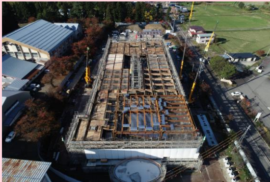
ドローンによる上空からの撮影 3階
