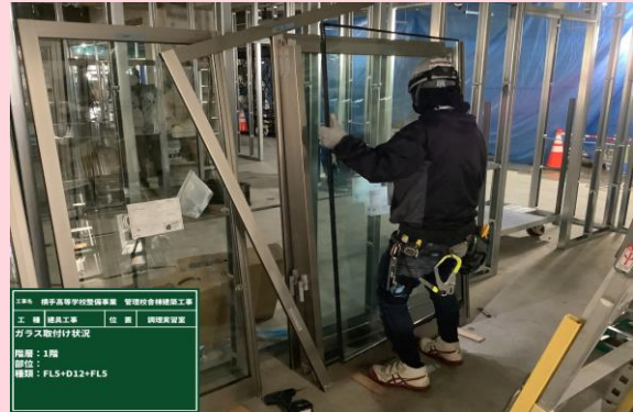
建具工事 1階 ガラス取付け状況
