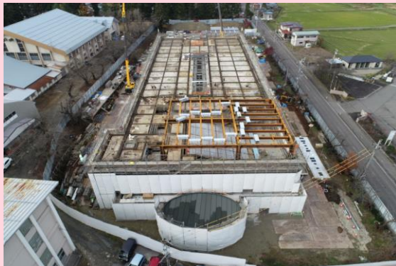
ドローンによる上空からの撮影 3階
