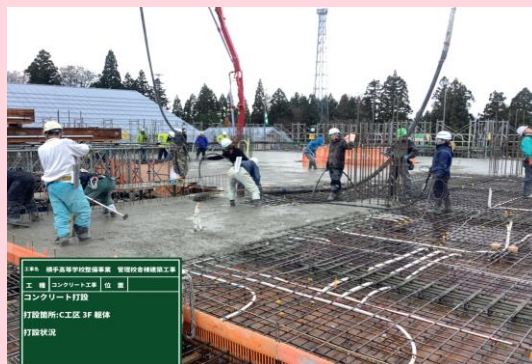
コンクリート工事 3階立上 打設状況
