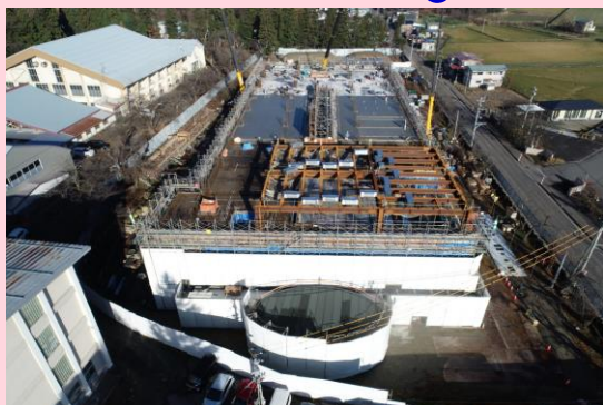
ドローンによる上空からの撮影 4階
